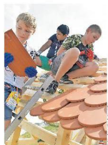
Beim Dachdecken wurde kräftig angepackt.
